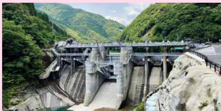
山須原ダム、改修工事終了！
